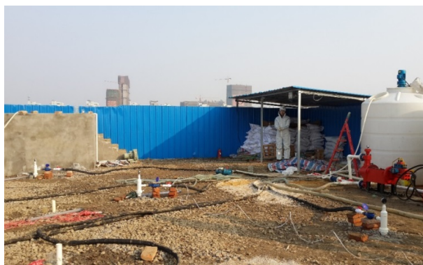
图 3 江苏省某场地进行原位化学氧化修复示范工程
